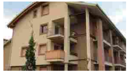
Appartamenti Mezzago XXV Aprile
