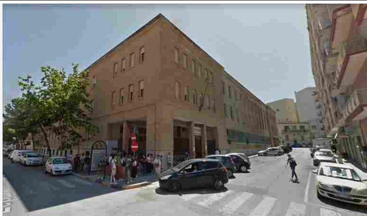
Istituto Comprensivo "G. Modugno – G. Galilei" di Monopoli © google.maps
