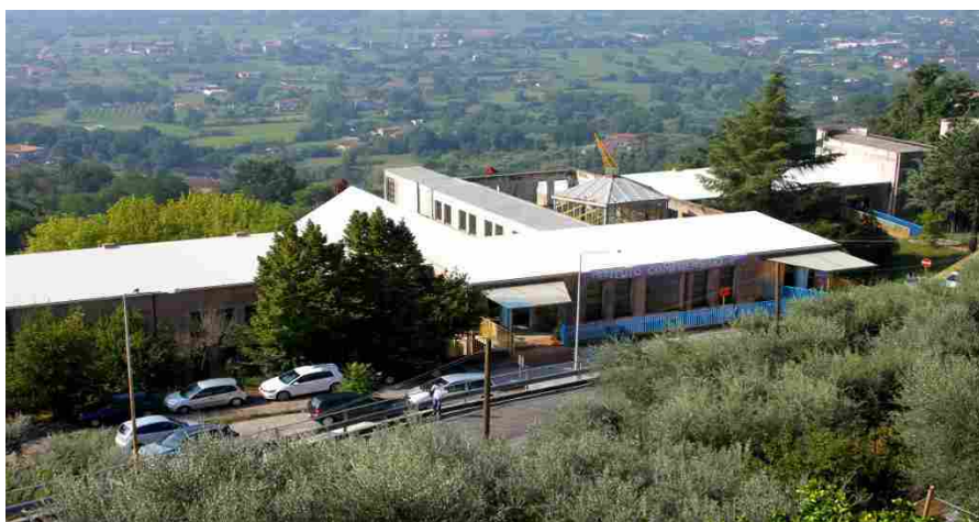
il plesso di via San Giorgetto del Secondo Istituto Comprensivo Anagni
